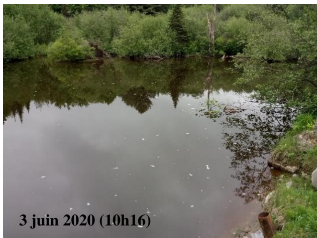
Figure 1. Vue de l'emplacement du tuyau de la prise d'eau, dans la rivière Chicot, dont l'eau est dirigée par gravité vers la fosse
